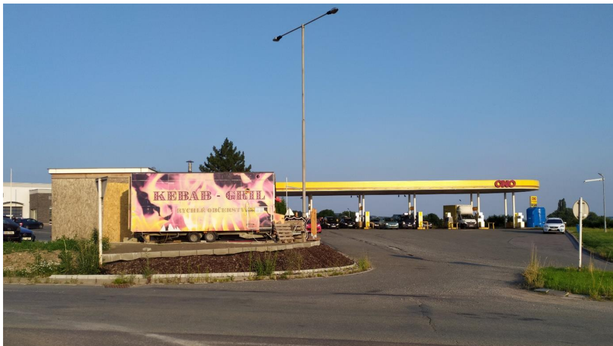
Obrázek 7: Čerpací stanice pohonných hmot poblíž silnice I/33 – stav k červenci 2021
