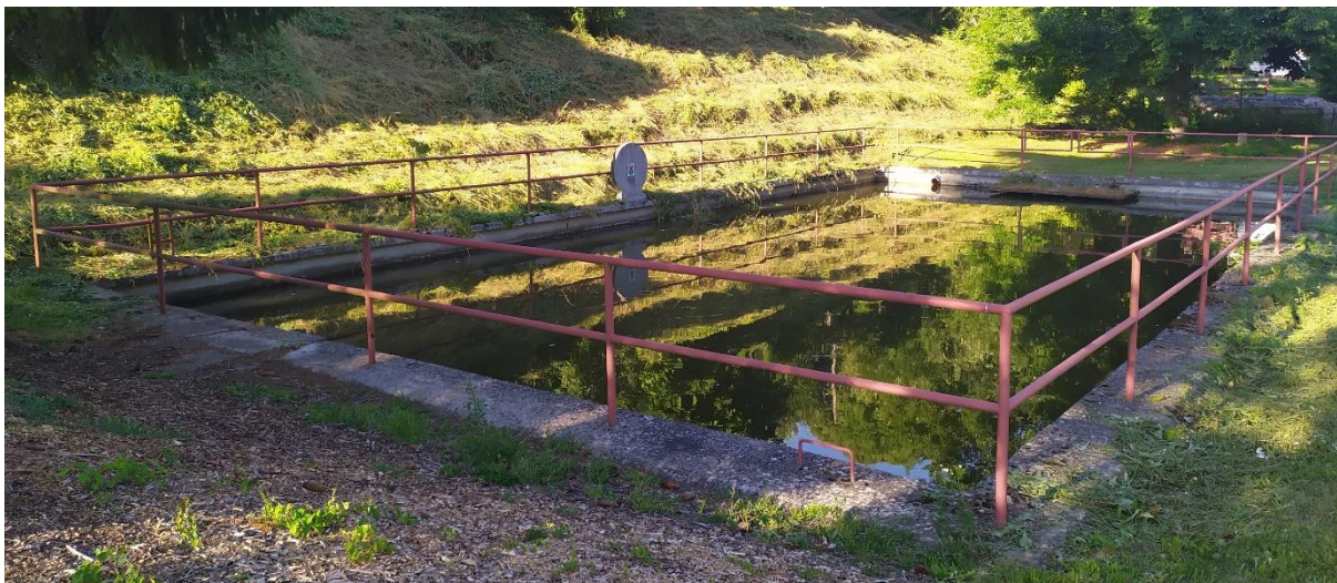
Obrázek 4: Požární nádrž jižně od budovy s č. p. 141 – stav k červenci 2021
