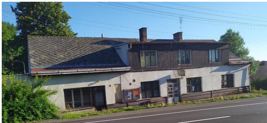
Obrázek 15: Budova s č. p. 71 – stav k červenci 2021
